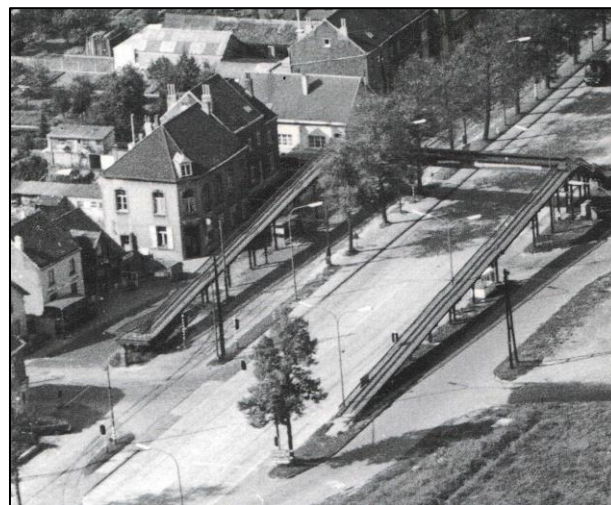
De voetgangersbrug over de tramsporen en de Nieuwelaan, ter hoogte van de Boechtstraat.
